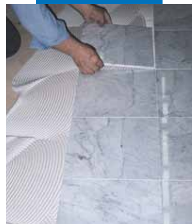
Montaj marmură de Carrara pe suport din lemn cu Keralastic alb
