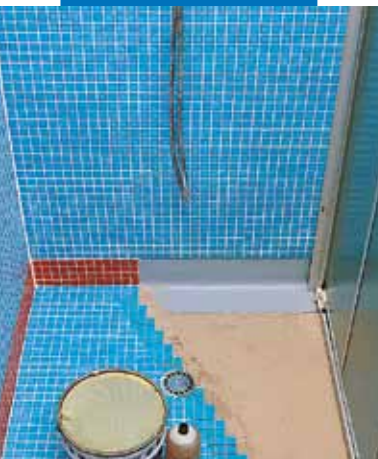
Hidroizolare și lipire mozaic la băi prefabricate
