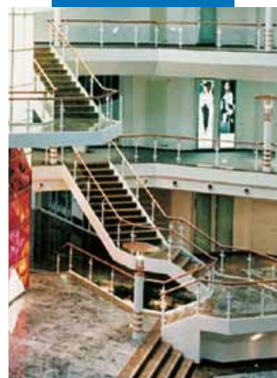
Exemplu de realizare a plăcilor cu plăci ceramice și marmură pe o structură metalică (scară)
