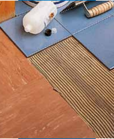
Lipire plăci ceramice pe pardoseală din covor PVC
