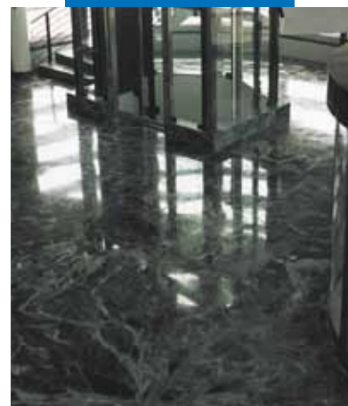
Pardoseală din marmură verde „Alpi” realizată în holul sediului Rolex (Bienne - Elveția)
