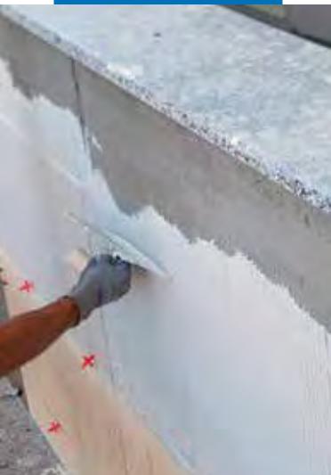
Placare pe o fatada la exterior: aplicarea adezivului pe suport
