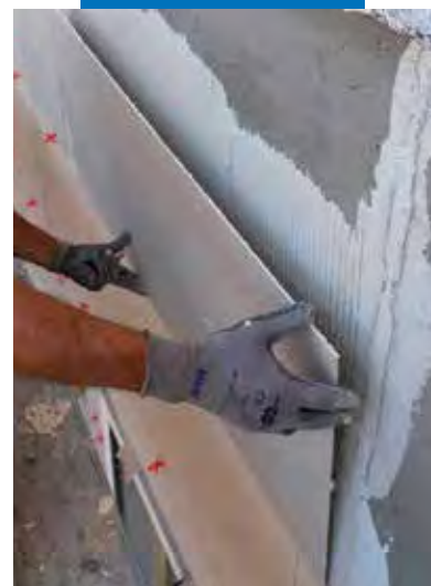
Aplicarea unei placi portelanate subtiri pe o fatada la exterior
